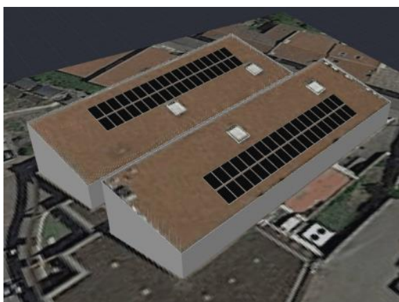
Médiathèque "Le SHED" : 36 kWc
